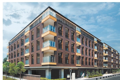
福祉施設施工例
