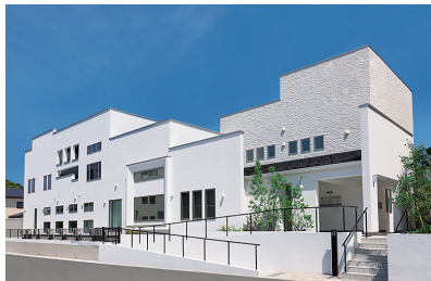
クリニック施工例
