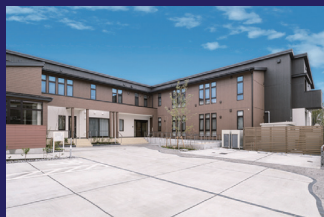
福祉施設施工例
