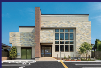
クリニック施工例
