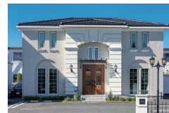
商業施設施工例
