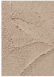
コテランダム仕上げ
